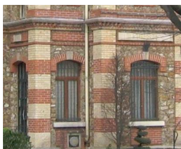
Détails de la façade principale de la mairie
