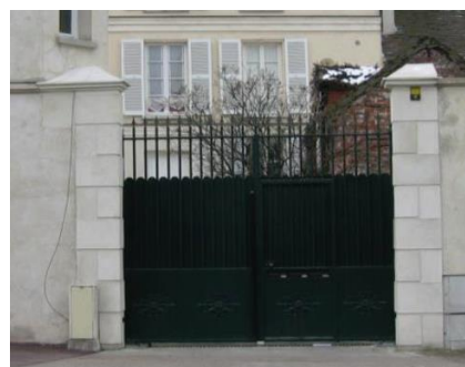
Détails du portail d'entrée de la maison
