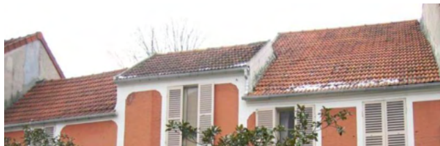
Détails de l'étage et des toits en tuile de la maison
