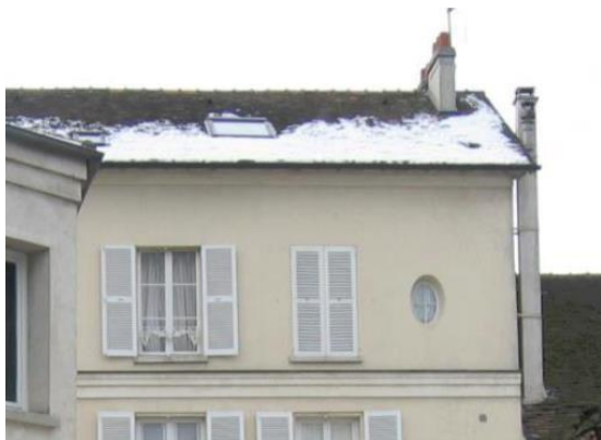
Détails de l'étage et du toit en ardoise de la maison
