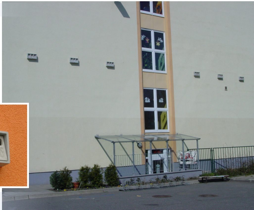
Nichoir à moineaux encastré dans l'isolation extérieure
