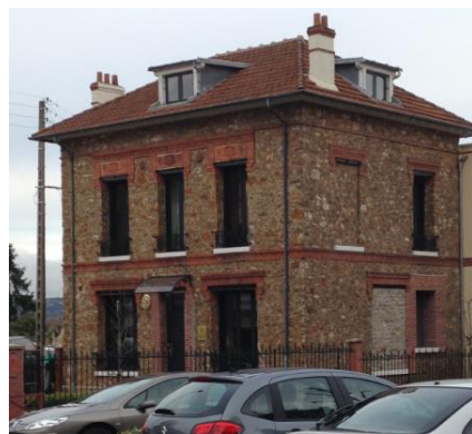
Maisons meulières du centre-ville
