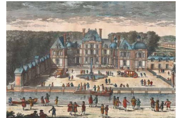
Façade du Château de Berny
