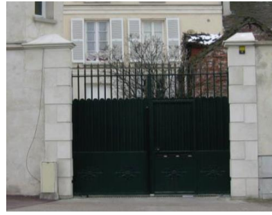
Détails du portail d'entrée de la maison
