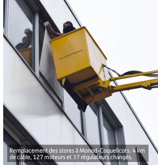
Remplacement des stores à Monod-Coquelicots : 4 km de câble, 127 moteurs et 37 régulateurs changés.
