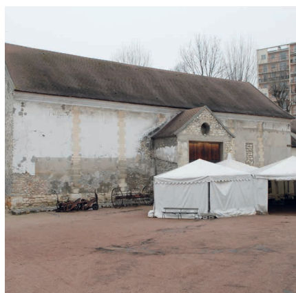
La Grange d'îmière en 2010, avant les travaux.
